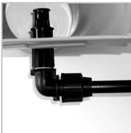
3. An die 3P Rückspül-Vorrichtung wird das 1/2" PE-Rohr mit dem 90°-Winkel angeschlossen. PE-Rohr durch das Leerrohr in den Technikraum ziehen.
